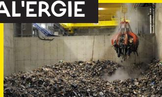
L'unité de valorisation énergétique située à Ludres, transforme les déchets incinérés en énergie électrique et thermique qui sert notamment à chauffer les grands ensemble d'habitation situés à Vandoeuvre.
